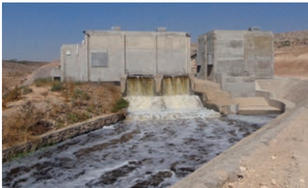
Turbinage des eaux usées d'As Samra I et II, 2 x 815 kW et 1 x 400 kW, Jordanie
