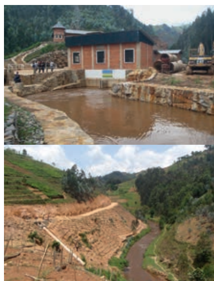
Supervision du projet de Rukarara II, 2 x 1 MW, Rwanda
