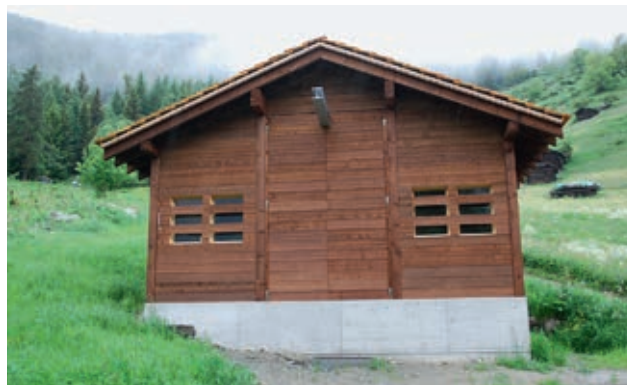
Turbinage des eaux potables de St-Jean, 105 kW, Suisse
