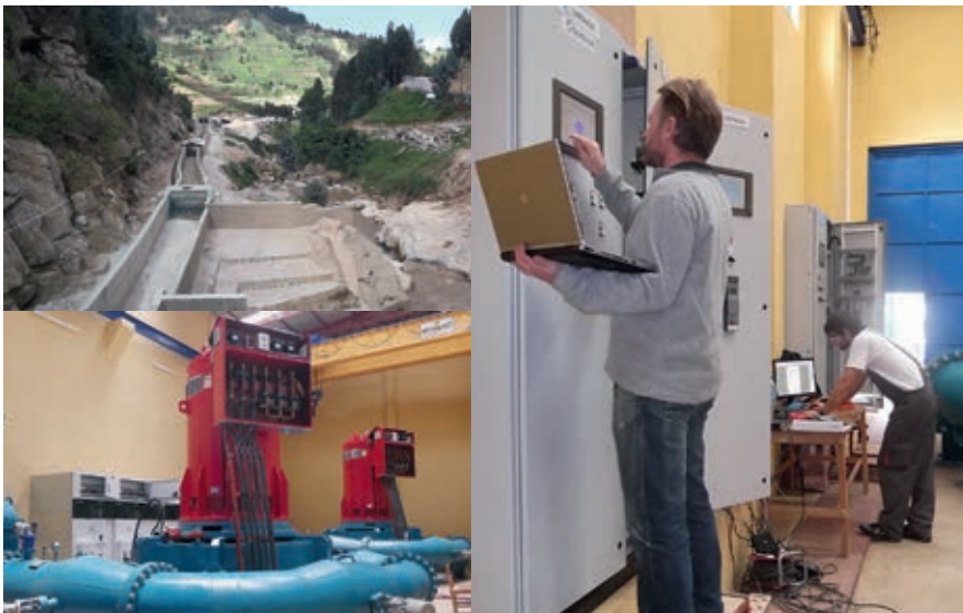
Suivi de réalisation de la centrale de Giciye, 2 x 2 MW, Rwanda
